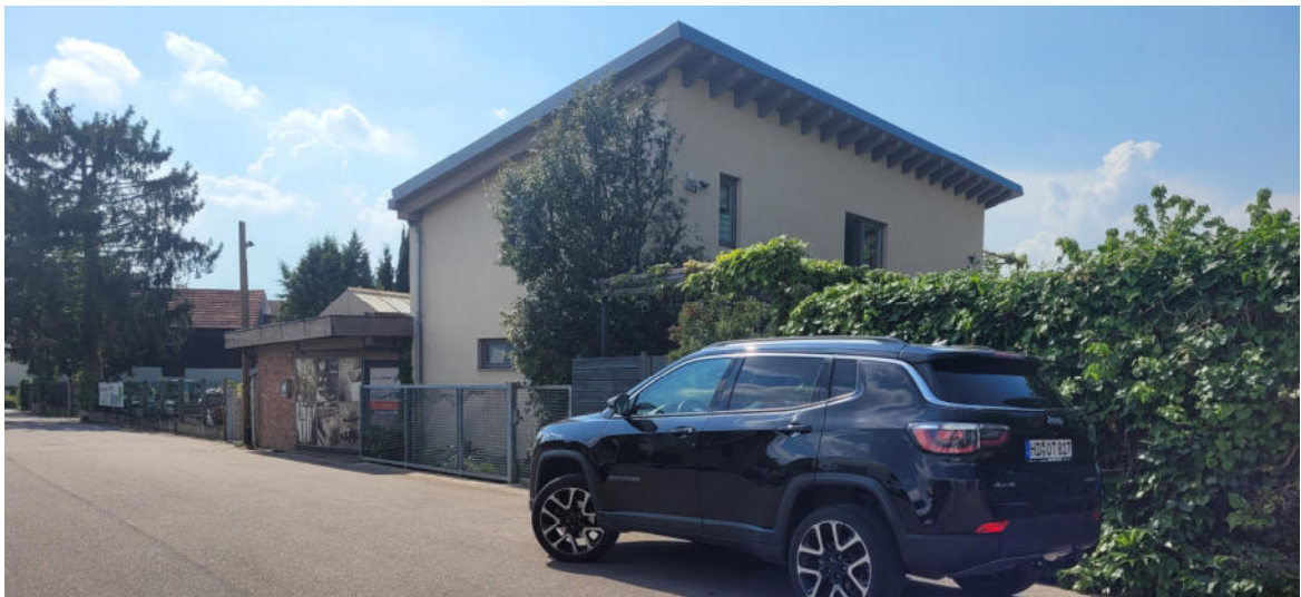
Bild 7: Wohngebäude Bestand – Ansicht Südosten
